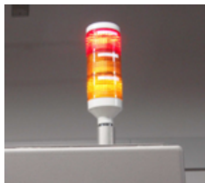
図3 外部照射ランプ
